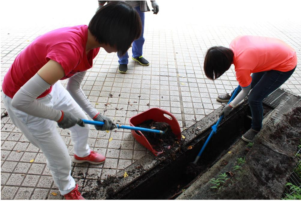
圖 7 水溝底部淤泥徹底清除
